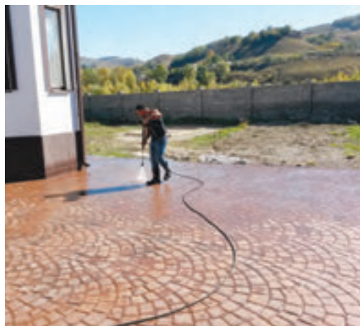
ОТМЫВКА РАЗДЕЛИТЕЛЯ ДО НЕОБХОДИМОГО ОТТЕНКА
