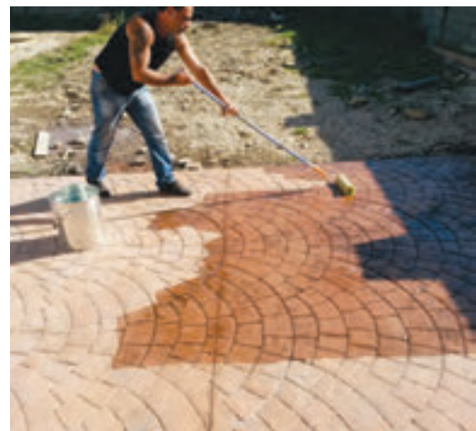
ВСКРЫТИЕ ПОВЕРХНОСТИ ФИНИШНЫМ ЛАКОМ
