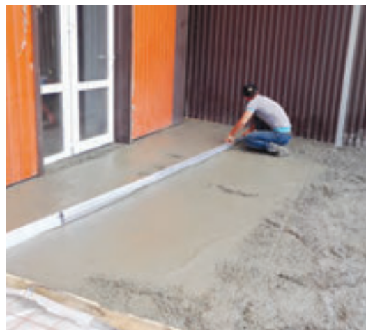
УКЛАДКА БЕТОНА С УЧЕТОМ НЕОБХОДИМЫХ УКЛОНОВ
